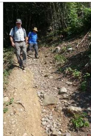
**Waldstätterweg, Alpnachstad - Renggpass:** Abfliessendes Hangwasser auf diesem steilen Abschnitt führt zu starker Erosion. Die intensive Benutzung durch Mountainbiker verstärkt die Abtragung und gefährdet Wanderer an engen Passagen.
