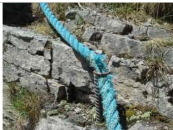
**Sanetsch- Muveran, Col du Sanetsch – Le Godé:** Die Seile zur Sicherung des Auf- und Abstiegs auf diesem Bergwanderweg haben ausgedient. Die Fixierungen sind teilweise gelockert und die Seile rissgefährdet.
