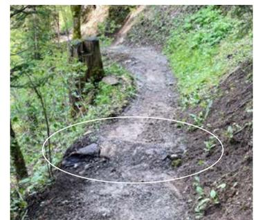
Abb. 53 Mit Steinen verstärkter Kieswall
