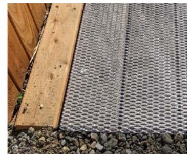
Abb. 71 Rutschfestigkeit der Gehfläche mit Streckmetall
