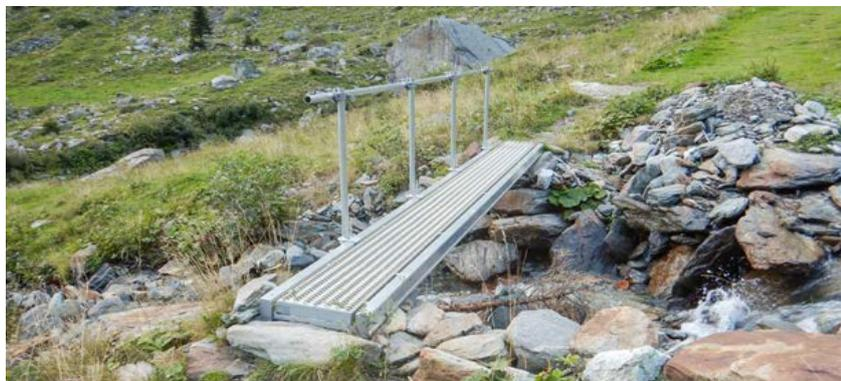
Mobile Brücken aus Aluminium eignen sich je nach Bauweise für die Überbrückung von Spannweiten bis maximal 10 Meter. Bei grösseren Spannweiten wird die Konstruktion für die Montage und Demontage von Hand zu schwer oder erfüllt die notwendige Tragfähigkeit nicht. Spezialanfertigungen werden beispielsweise von Unternehmen aus dem Gerüstbau hergestellt.
