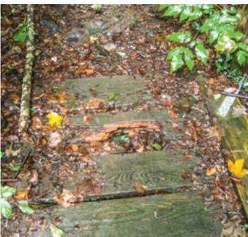
Abb. 111 Nasses Altlaub lässt Holzteile vermodern.
