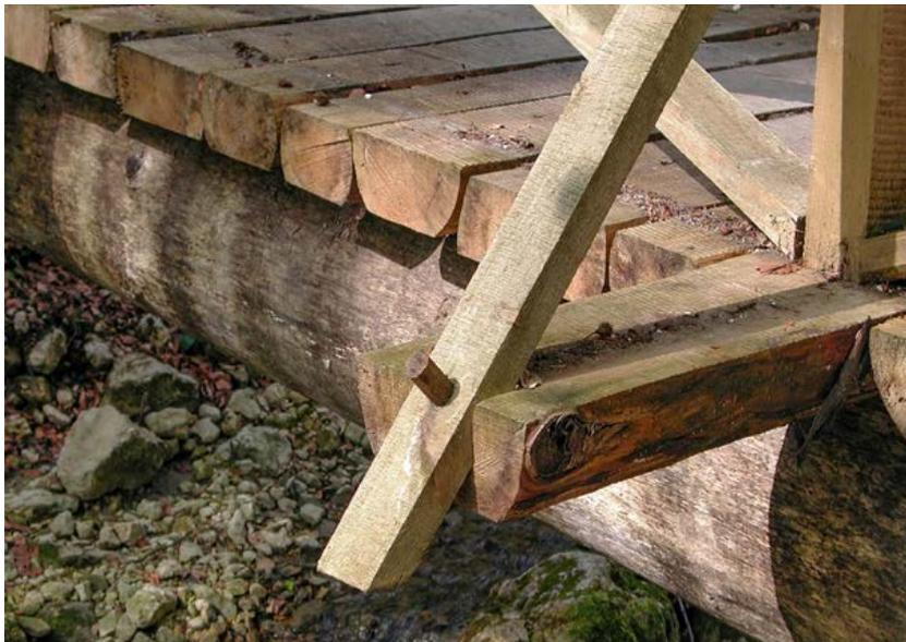
Abb. 69 Details des Haupttragwerks einer Holzbrücke
