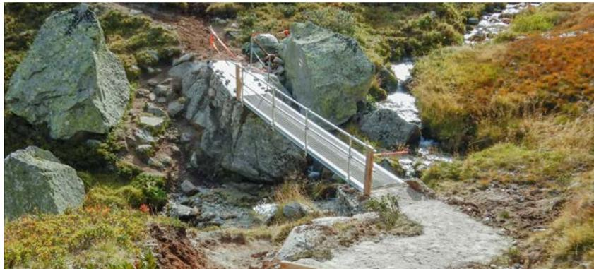
Abb. 74 Mobile Brücke aus Aluminium zur Überwindung eines Bachlaufs
