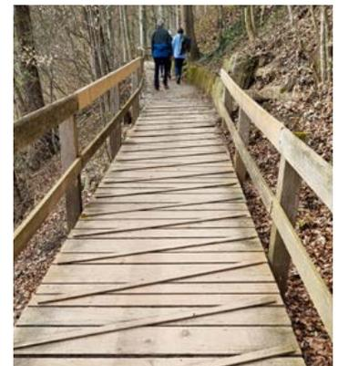
Abb. 70 Rutschfestigkeit der Gehfläche mittels schräg gestellter Hölzer
