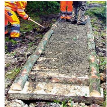
Abb. 19 Bedecken des Bohlenwegs mit Bodenmaterial und Schotter
