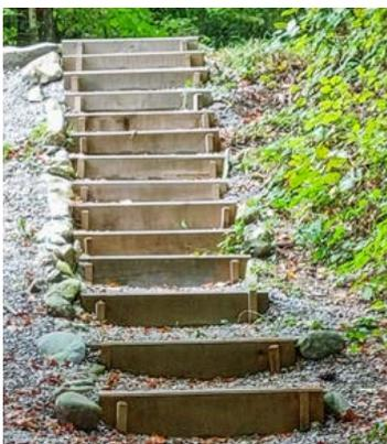
Abb. 79 Holztreppen mit Hinterfüllung
