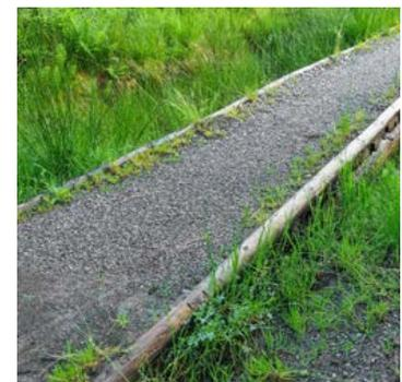
Abb. 20 Mit Schotter bedeckte Gehfläche eines Prügelwegs. Die Beständigkeit von Prügel- und Bohlenwegen erhöht sich noch weiter, wenn das Holz auch seitlich mit Bodenmaterial eingepackt wird.
