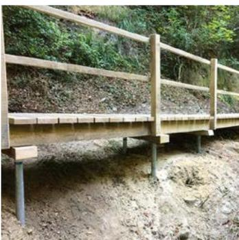
Abb. 68 Schraubfundamente sind eine Alternative zu massiven Widerlagern.
